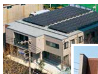
屋上に太陽光パネルを設置
